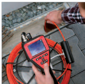
Inspectie van afvoerbuizen
