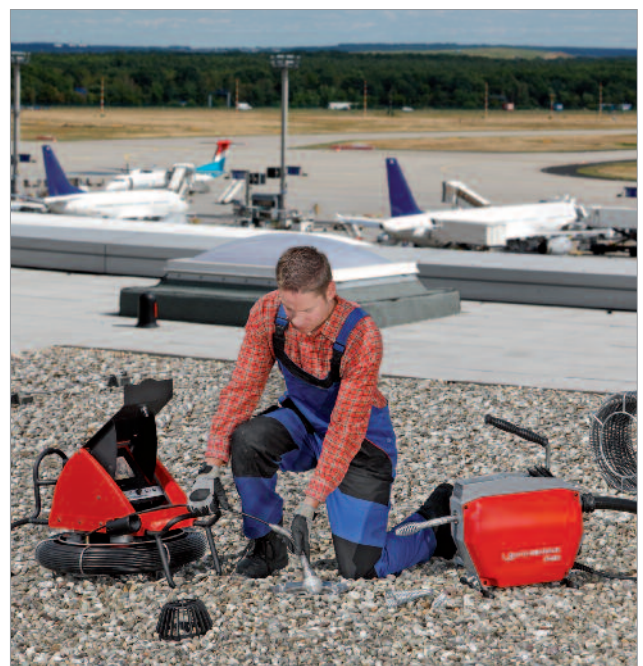
Inspectie van een regenafvoer
