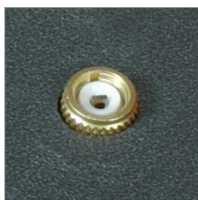
5/16" SAE adapter voor aansluiting aan R410-installaties
